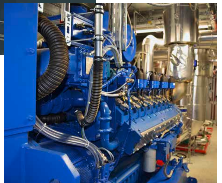
Von der neuen Energiezentrale aus versorgen ein 800-kW el -Blockheizkraftwerk, eine Adsorptionskältemaschine und ein zuschaltbarer Spitzenlastkessel die Schokoladenproduktion
